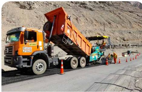
**INSTALACIÓN DE 35.000 M<sup>2</sup> DE NUEVA CARPETA ASFÁLTICA.**
